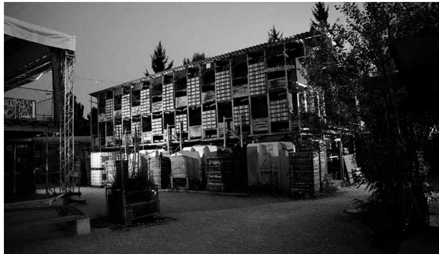
Die Transformation von Container City zu IBA Maker City in Stuttgart ist im Fokus eines Dokumentarfilms des Autors, welcher für 2023 erwartet wird. Foto – Studio Umschichten | Benjamin Bischof 2022
