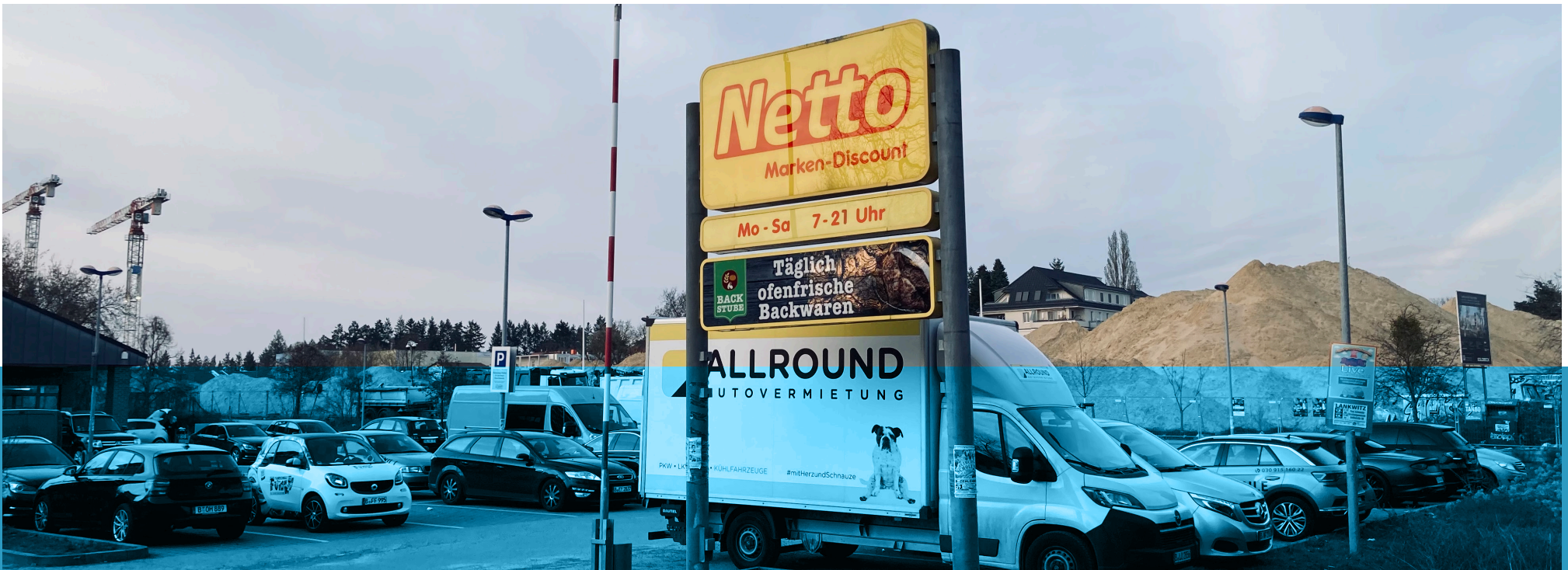
Abb.28 Baustelle Marienhöfe Attilastrasse | Buchholz 2026
