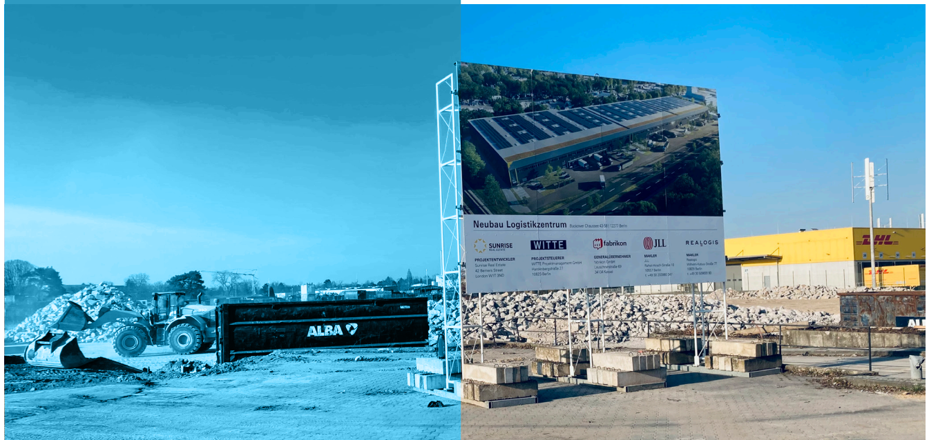
Abb.22 Neubau Logistik Buckower Chaussee | Buchholz 2026
